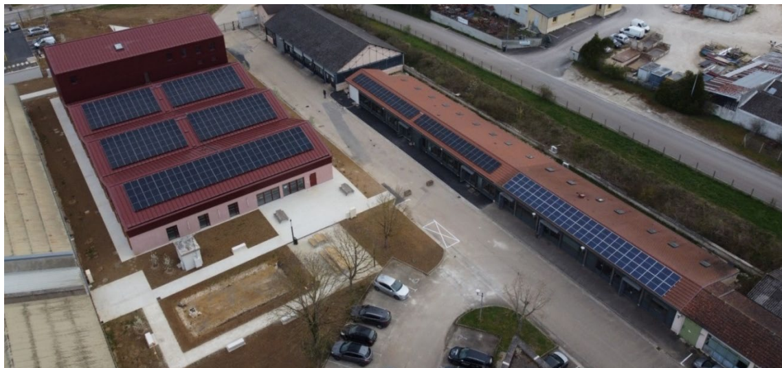
Panneaux d'une capacité de 100 kWc* , installés sur les versants sud du bâtiment
